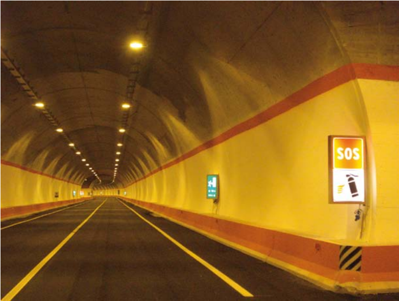
Interno della galleria
