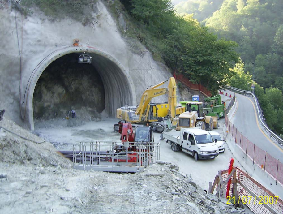
Dima imbocco di valle da cui è stata scavata la galleria
