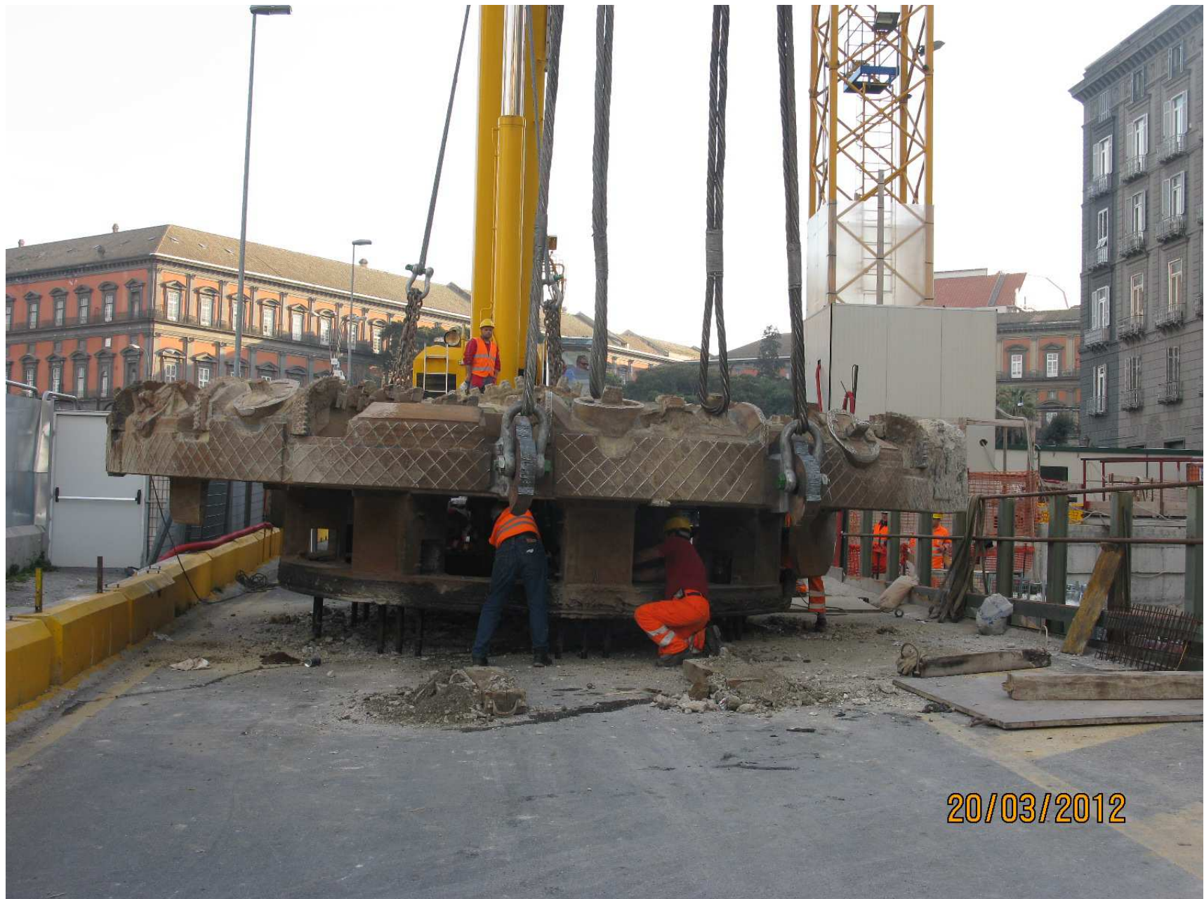
Pozzo di estrazione della TBM a Municipio
