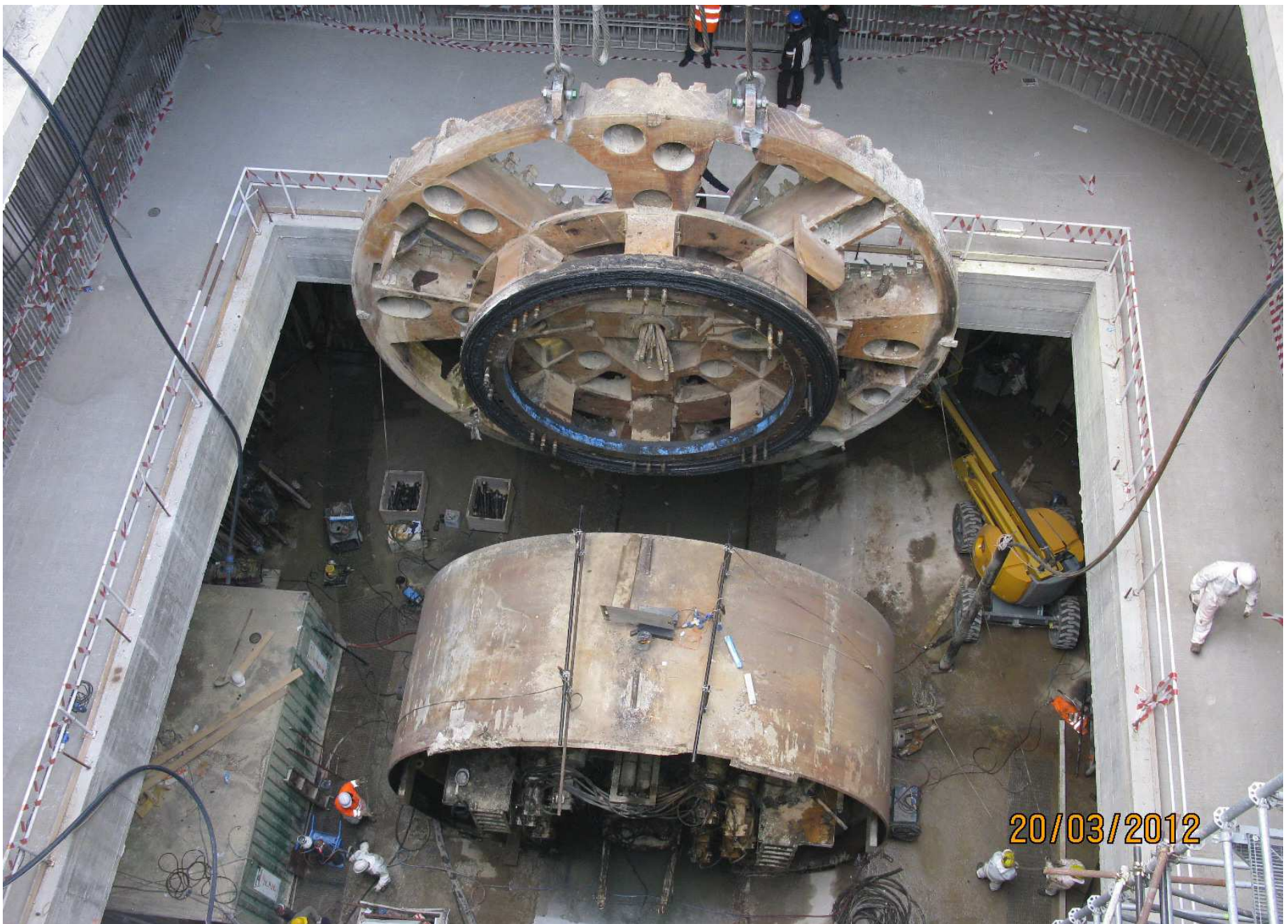
Pozzo di estrazione della TBM a Municipio In corso l' estrazione della testa fresante
