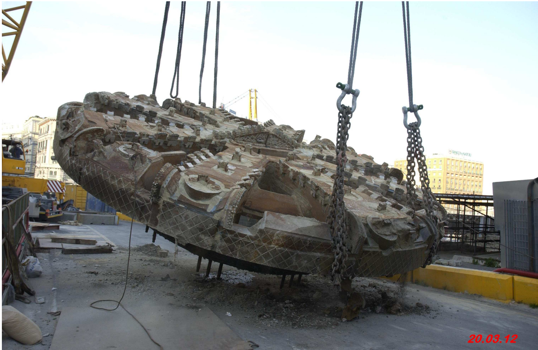
Pozzo di estrazione della TBM a Municipio In corso il ribaltamento della testa fresante per adagiarla al suolo e caricarla sul trailer
