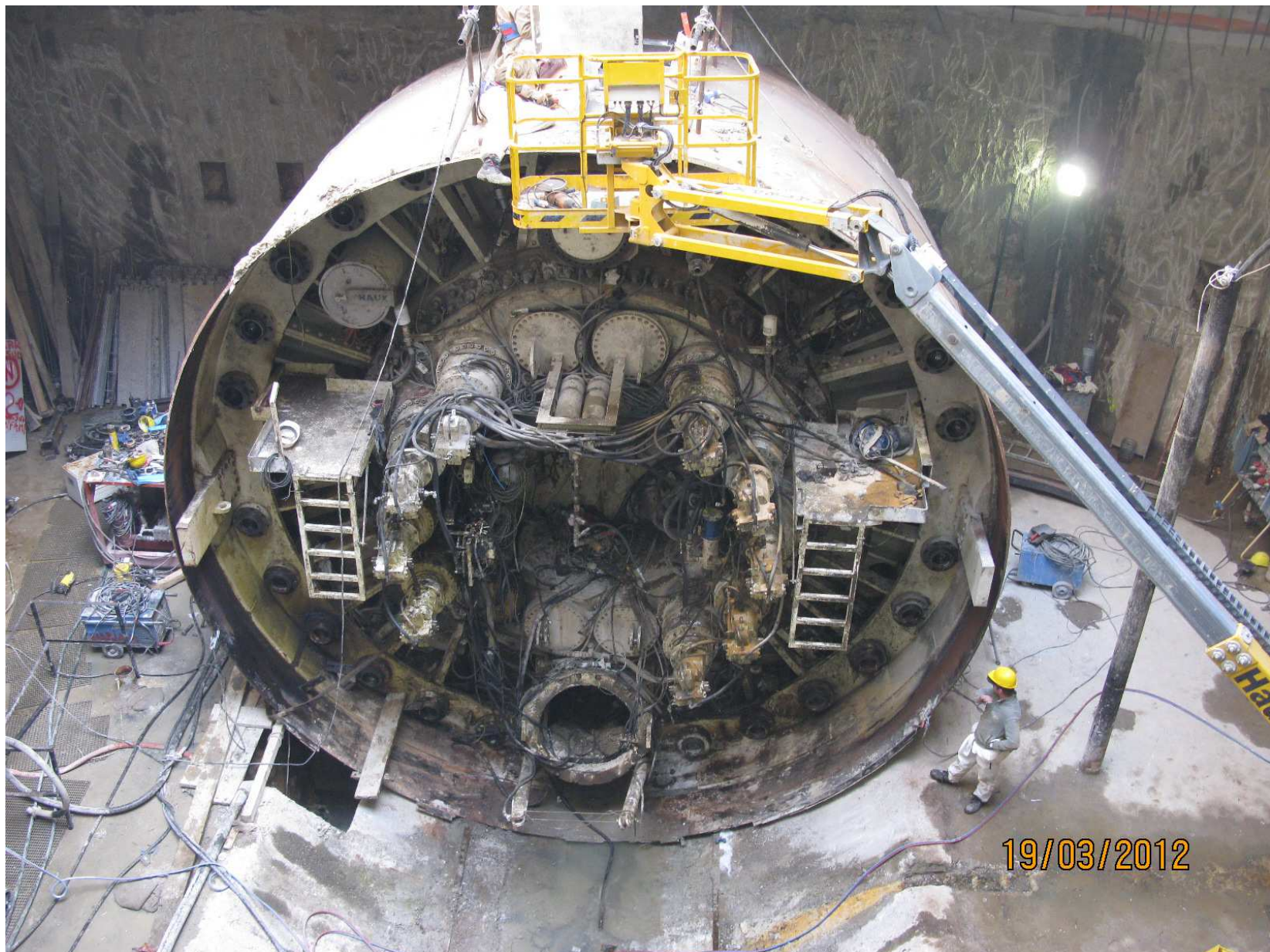
Pozzo di estrazione della TBM a Municipio Stato dei luoghi
