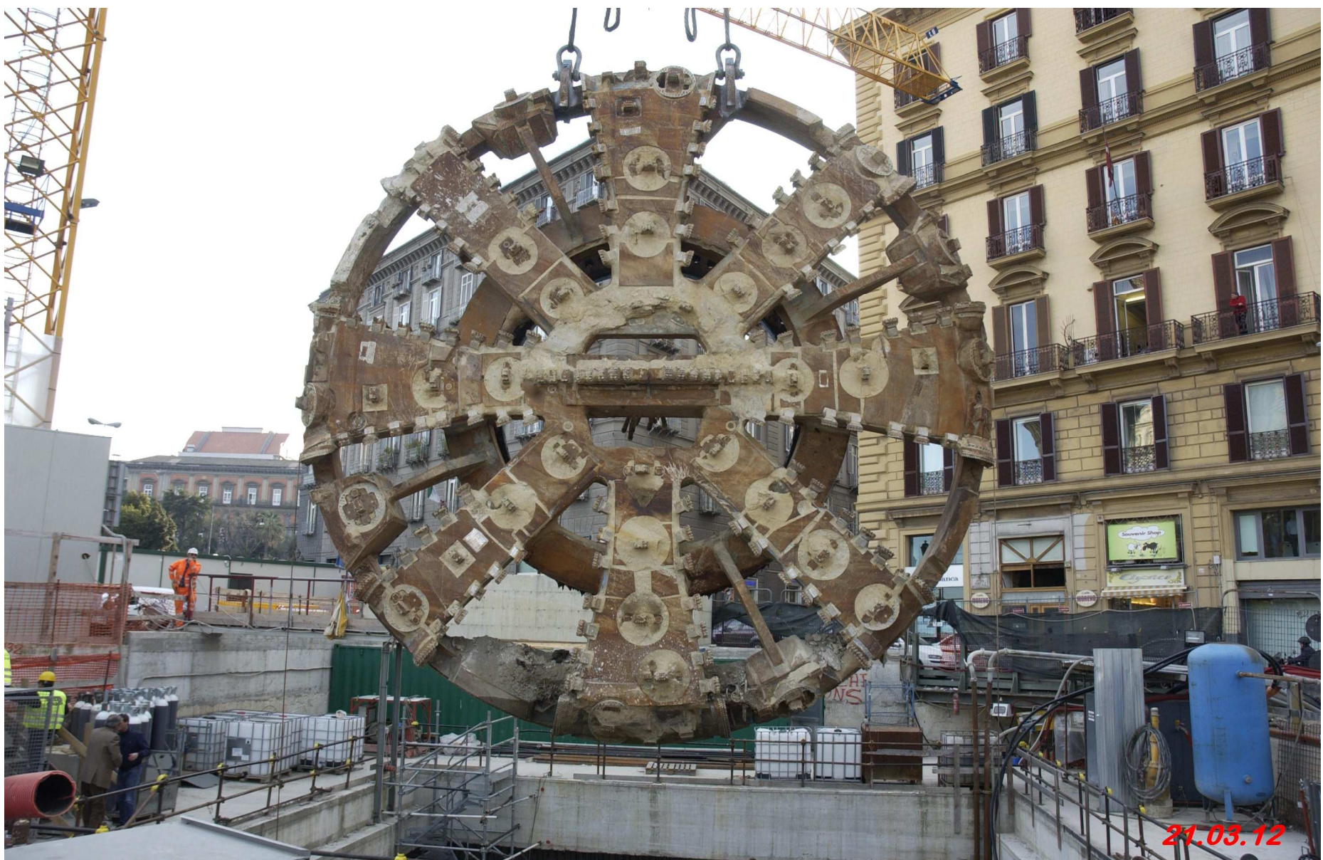
Pozzo di estrazione della TBM a Municipio In corso l' estrazione della testa fresante
