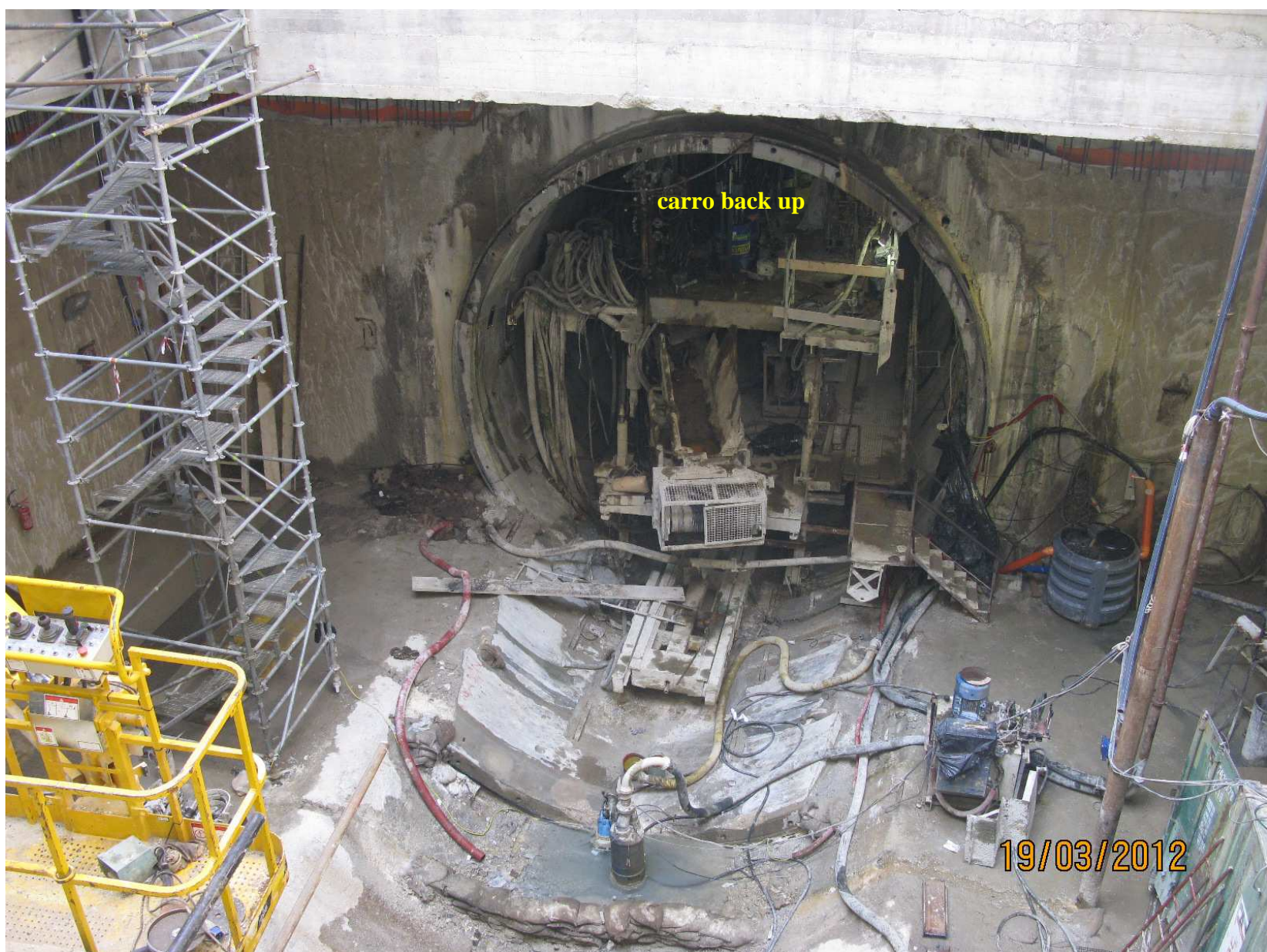
Pozzo di estrazione della TBM a Municipio Carro back up da estrarre
